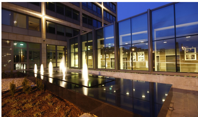
Siedziba biura ROVESE S.A. w Kielcach
